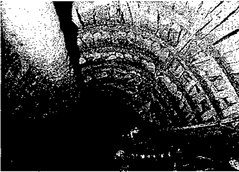
Şekil 7. Uygulama galerisinin çelik tahkimatlı ve püskürtme betonlu görünüşü
