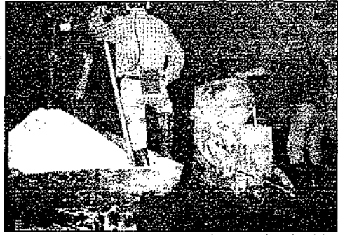
Şekil 4. Püskürtme beton harcının hazırlanması ve makinaya beslenmesi
