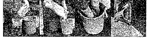
Şekil 8. Bristar ürününün uygun oranda su ile karıştırma işlemi [13]
