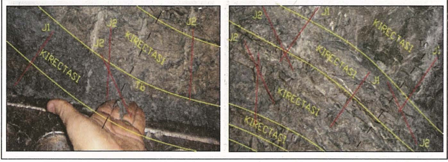
Şekil 9: Tünel kazı odasında yapılan detay çalışmalar. Tünel kazı aynasının bazı kesimlerinde görülen kireçtaşı, diyabaz daykı ve kalsit-kuvars dolgulu sistematik çatlaklar (Tb:Tabaka; Tn: Tabaka normali; J1;J2:Sistematik Çatlaklar)
