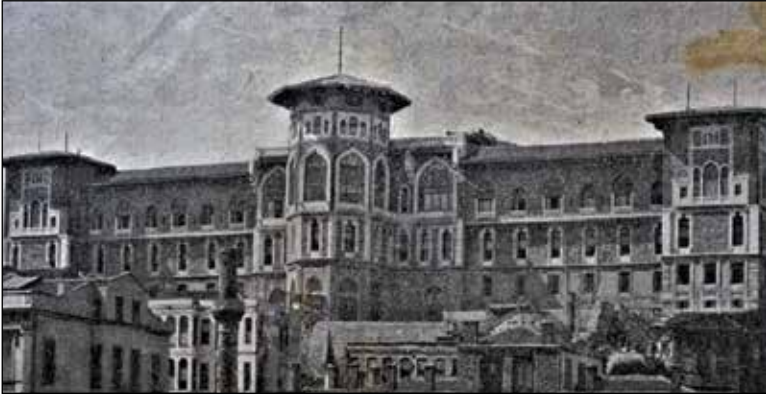
Fotoğraf 10. 1887'de inşa edilen Düyun-u Umumiye Binası
