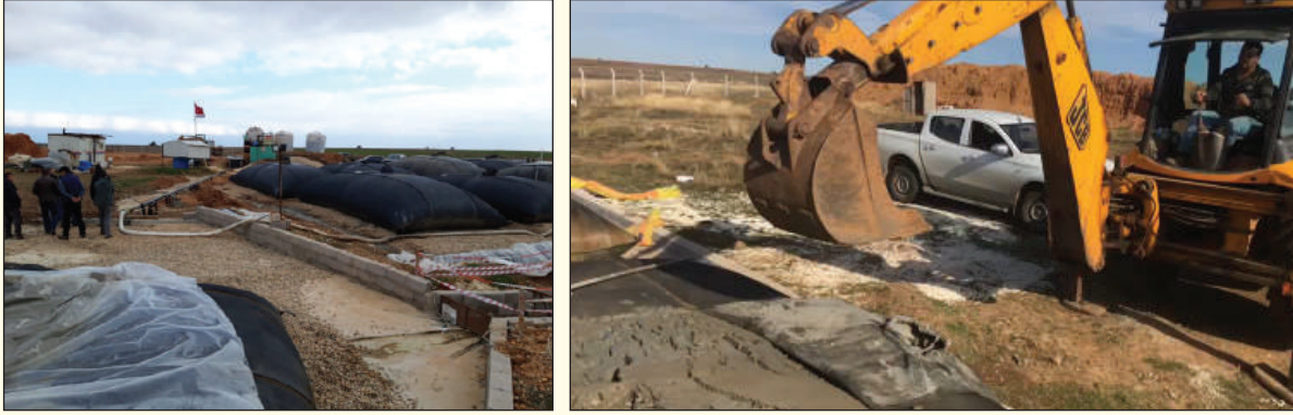
Şekil 6. jeotekstil tüp ile susuzlandırma ve nihai çamur
