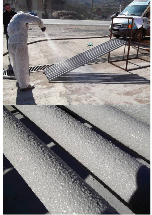
Şekil 7. Poliürea püskürtülerek kaya saplamalarının kaplanması ve kaplanmış saplama yüzeyi
