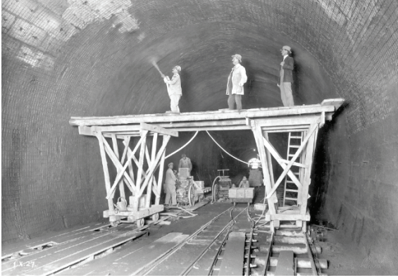
Şekil 8. Ulmberg demiryolu tüneline 1927 yılındaki püskürtme beton uygulaması (Kovari, 2013a)
