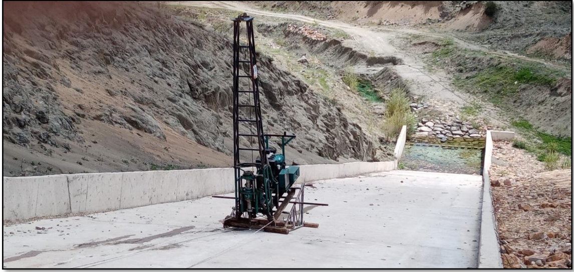
Şekil 2. Temel sondaj çalışmalarından görünüm
