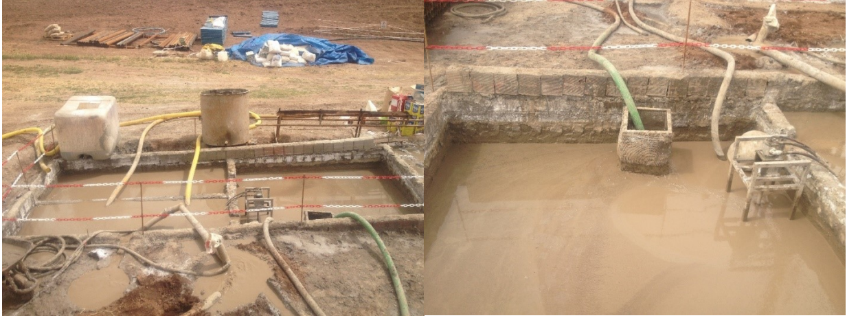
Şekil 15. Çamurun sürekli olarak hareketli olmasının sağlanması
