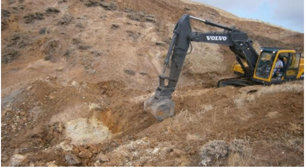
Foto 1. Yarma açma çalışmaları
