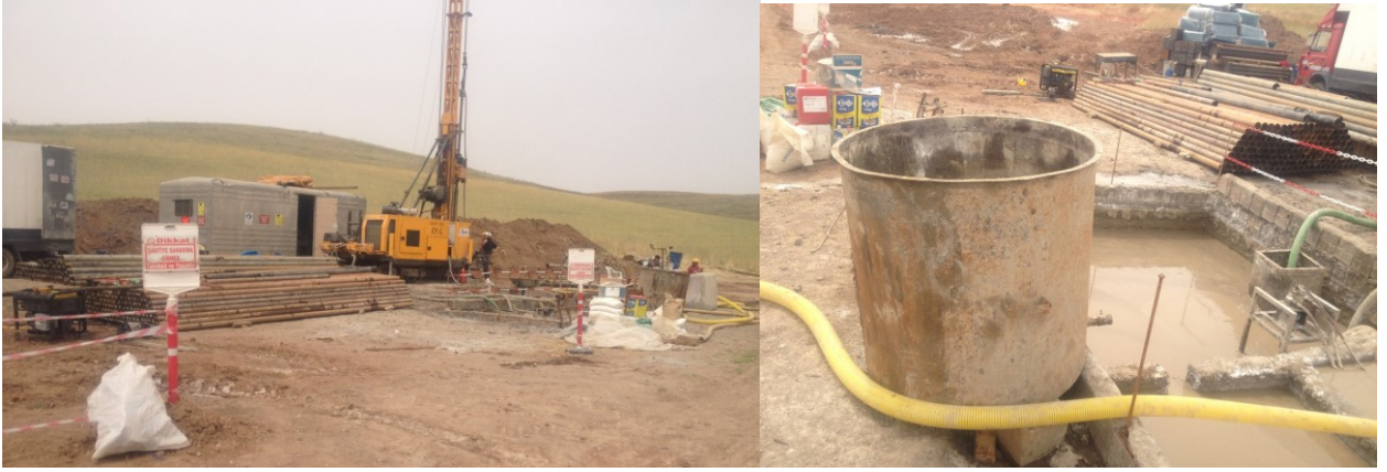
Şekil 9. SON-MAK RX-6 sondaj makinası ve tuza doymuş çamur hazırlama tankı
