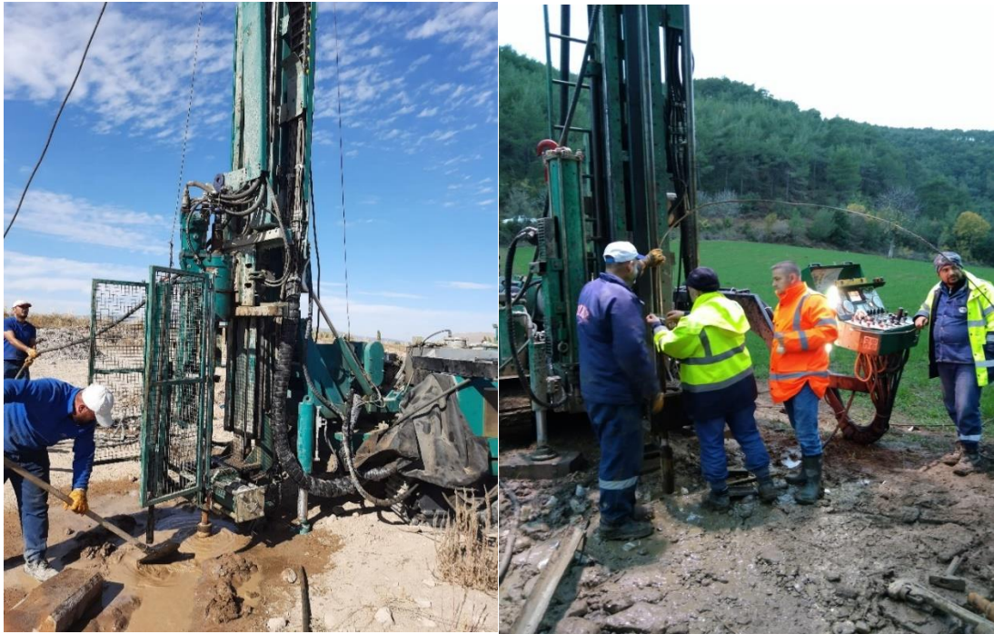
Şekil 1. Temel sondaj çalışmaları
