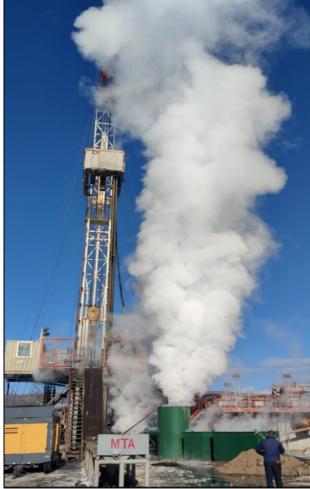
Şekil 5. Kütahya-Simav sahasında açılan jeotermal kuyudaki üretim testleri
