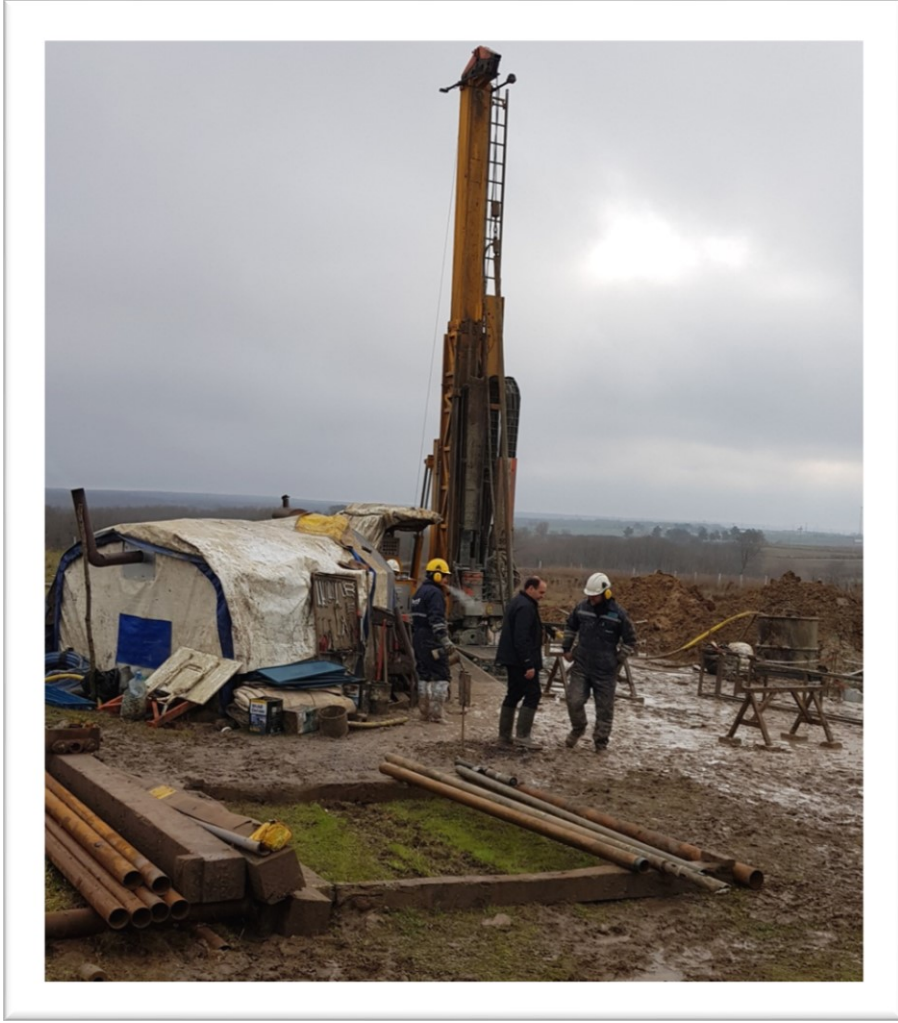
Şekil 1. Bu çalışma kapsamında açılan jeoteknik sondajlardan birinin görüntüsü (7 numaralı sondaj) (10-11 Ocak 2018)
