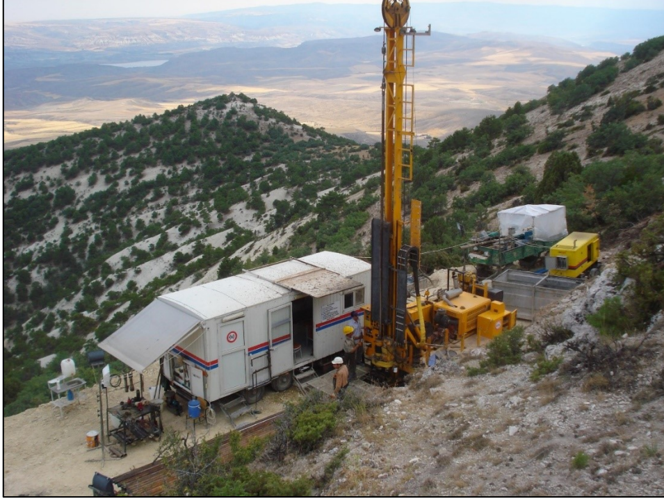
Şekil 7. Zor arazi koşullarında yapılan sondaj çalışmaları
