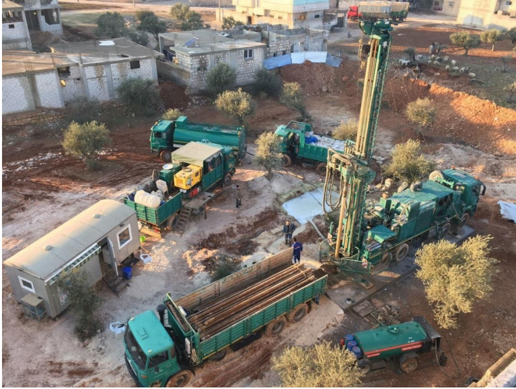
Şekil 9. Suriye su sondaj çalışmalarından görünüm
