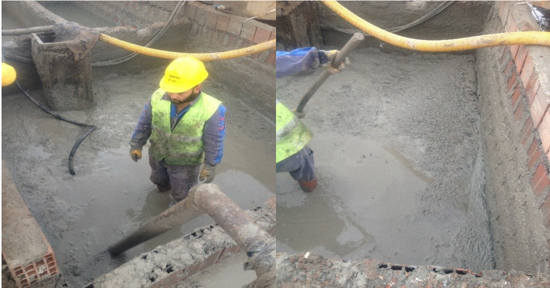
Şekil 14. Çamur havuzundaki topaklanmadan görünüm ve topaklanmış çamurun havuzlardan boşaltılması işlemi
