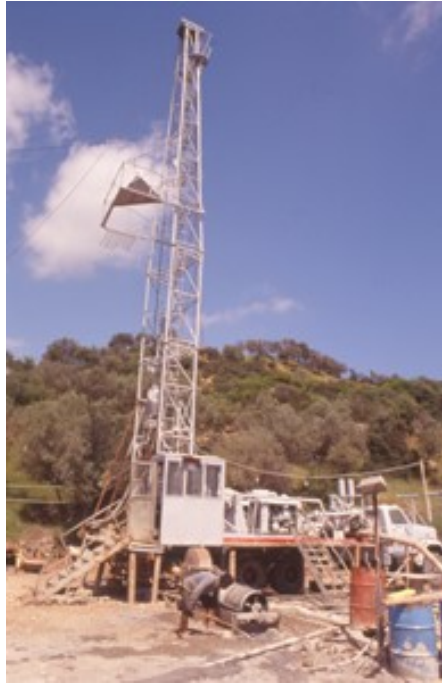
Şekil 1. Sondaj çalışmalarından bir görüntü
