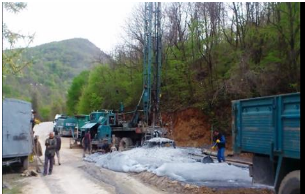
Şekil 6. Su sondaj çalışmaları
