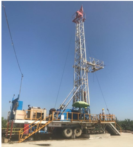
Şekil 1. Üretim kuyularının açılması işleminden bir görünüm.
