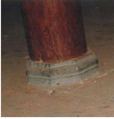
Resim 7. Ahşap direklerin doğaltaş tabanları
