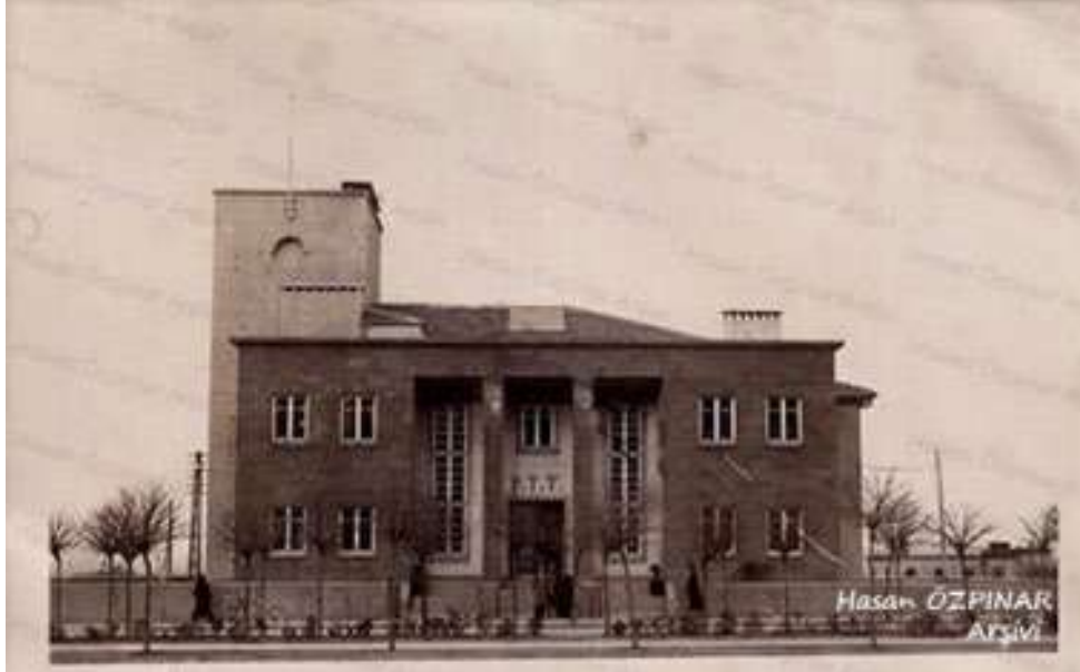
Şekil 5. Merkez PTT Binası (URL 7)
