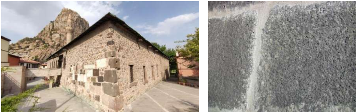
Resim 6. Camide beden duvarında kullanılan taş türleri (URL 2)
