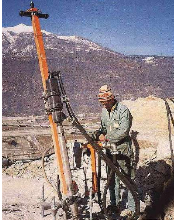
Şekil 2. Doğaltaş ocaklarında kullanılan tipik bir delme makinası ve tabancası
