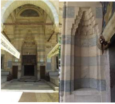
Resim 12. Taş kapı /portalı ve niş detayı
