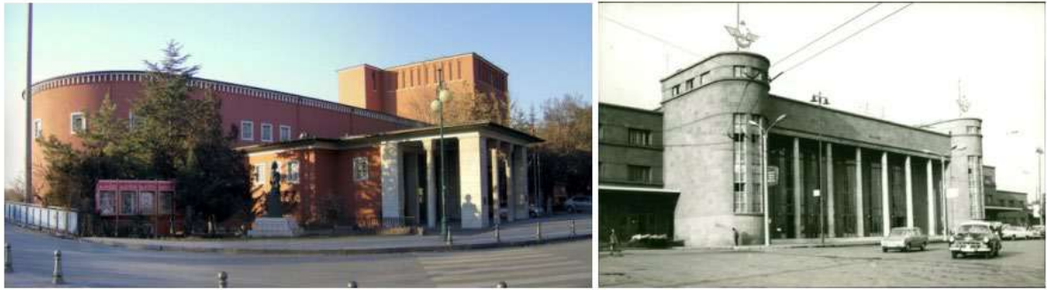
Şekil 3-4. Devlet Opera ve Balesi Binası, Ankara Tren Garı, 1935 (URL 4, 5)
