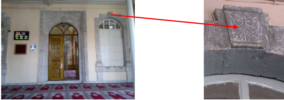
Resim 17. Son cemaat mekanı güney duvarı-Harim kapı detayı
